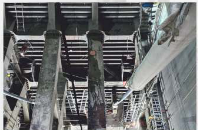
2000MW Subansiri HEP, Arunachal Pradesh
